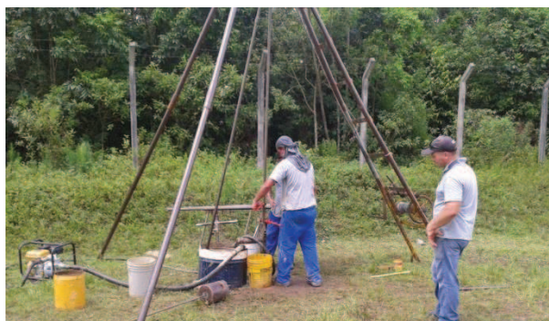
Foto 2. Detalhe da execução das sondagens SP-01.
