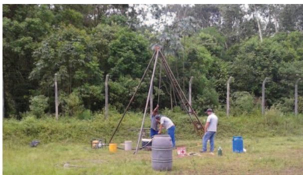
Foto 1. Execução das sondagens SP-01.
