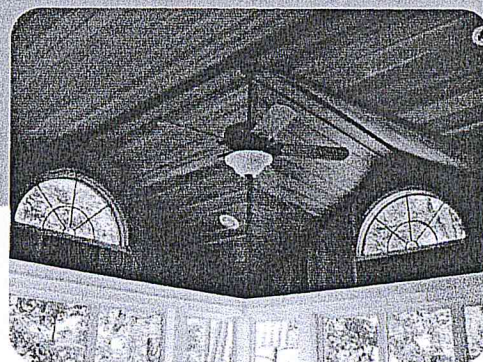
proteção de forro e vigas
