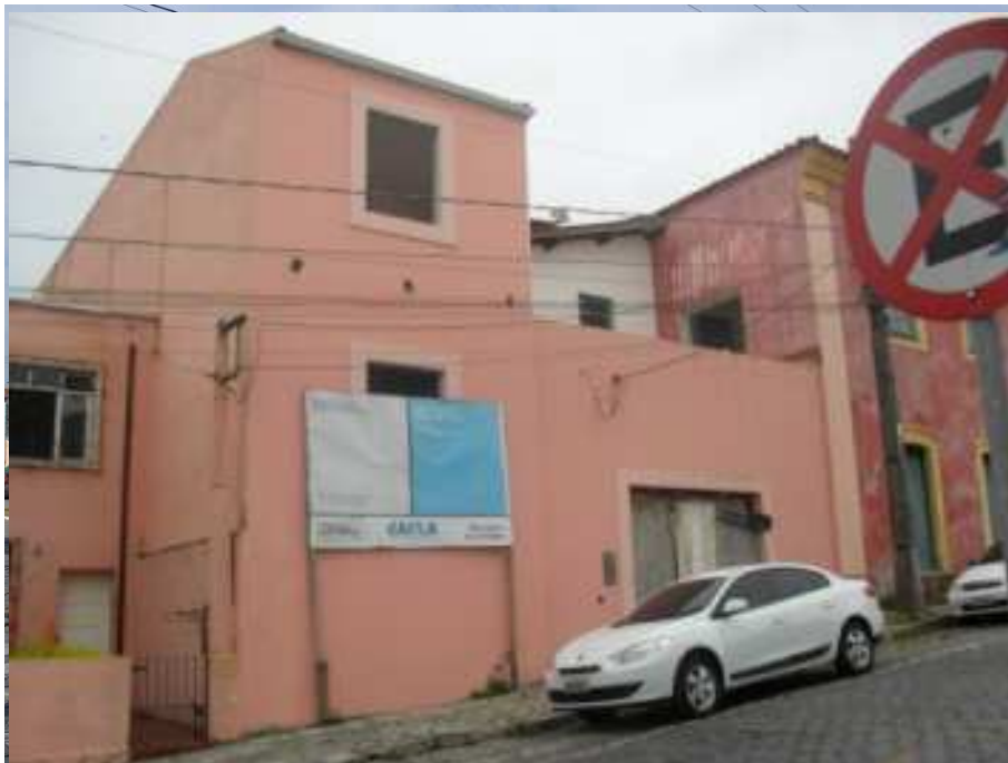
FOTO: Vista das Fachadas- Rua Conselheiro Sinimbu com a Rua João Regis. Data: 2009. (Fonte: Prefeitura Municipal de Paranaguá)
