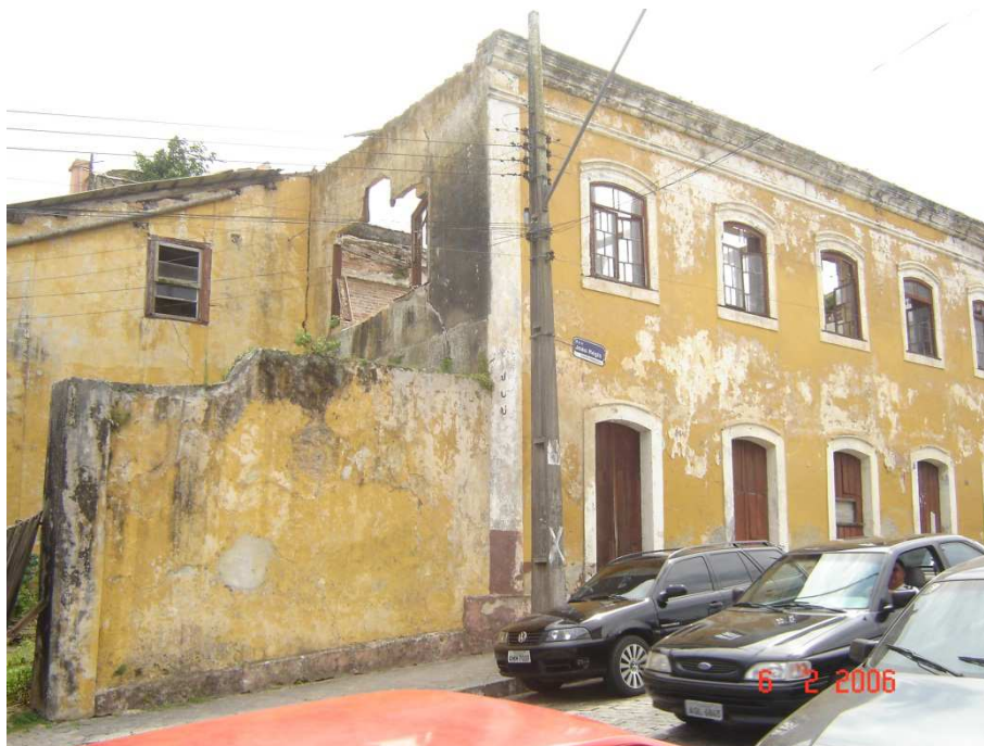
FOTO: Vista da Fachada - Rua João Regis. Data: 2006. (Fonte: Prefeitura Municipal de Paranaguá)
